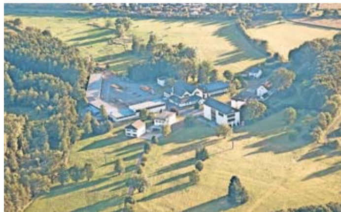
Das Wasserwerk in Inheiden lädt zum Tag der offenen Tür ein.
