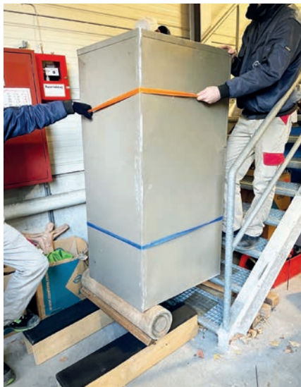
Kostet fast nichts in der Anschaffung, lässt sich aber effektiv und sicher nutzen: Richtig angewendet ist der Treppentransport mit Stufensetzer einfach.
