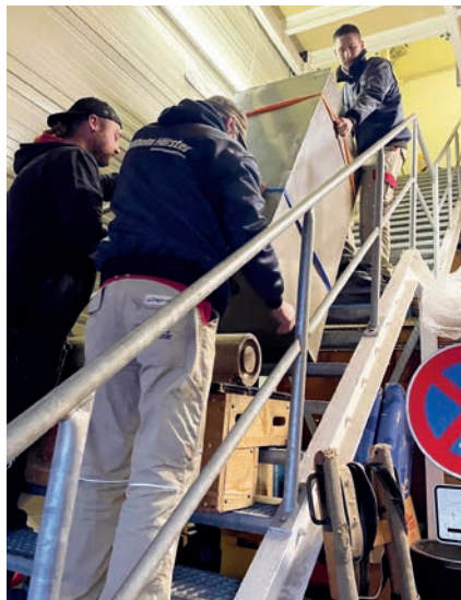
Kostet fast nichts in der Anschaffung, lässt sich aber effektiv und sicher nutzen: Richtig angewendet ist der Treppentransport mit Stufensetzer einfach.
