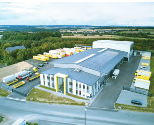
Umzug in eigener Sache: Ende 2021 ging es von Ohlweiler in den Nachbarort Simmern in einen komplett neuen Speditionsbau mit integrierter Lagerhalle. Fotos (2): Frey & Klein
