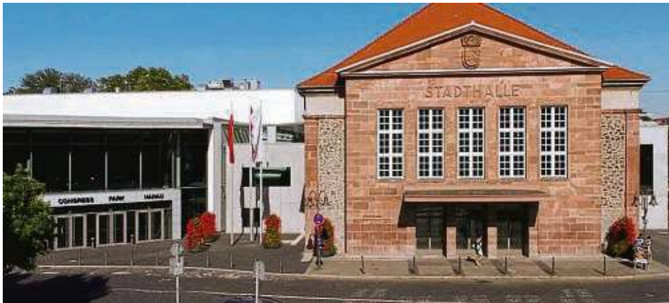
Trotz anfänglich kritischer Töne wegen der „Tankstellenarchitektur“: Congress Park Hanau und Stadthalle geben dem Hanauer Schlossplatz stadtgestalterisch Struktur. FOTO: CPH
