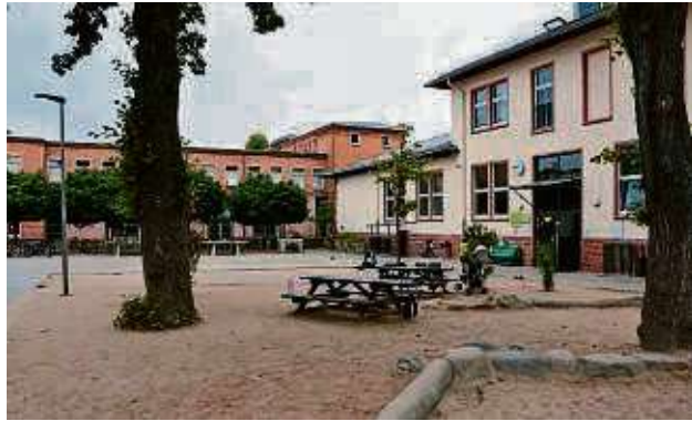
Das Gebäudeensemble der Sophie-Scholl-Schule wird um die Tümpelgarten-Schule (Backsteinbau im Hintergrund) erweitert. Dort soll ab Sommer 2024 eine viergruppige Kita einziehen.
