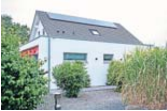
Mit einer Solaranlage auf dem Dach ist ein Haus unabhängiger vom Energiemarkt - und von seinen schwankenden Kosten. Foto: Laura Ludwig/dpa-mag
