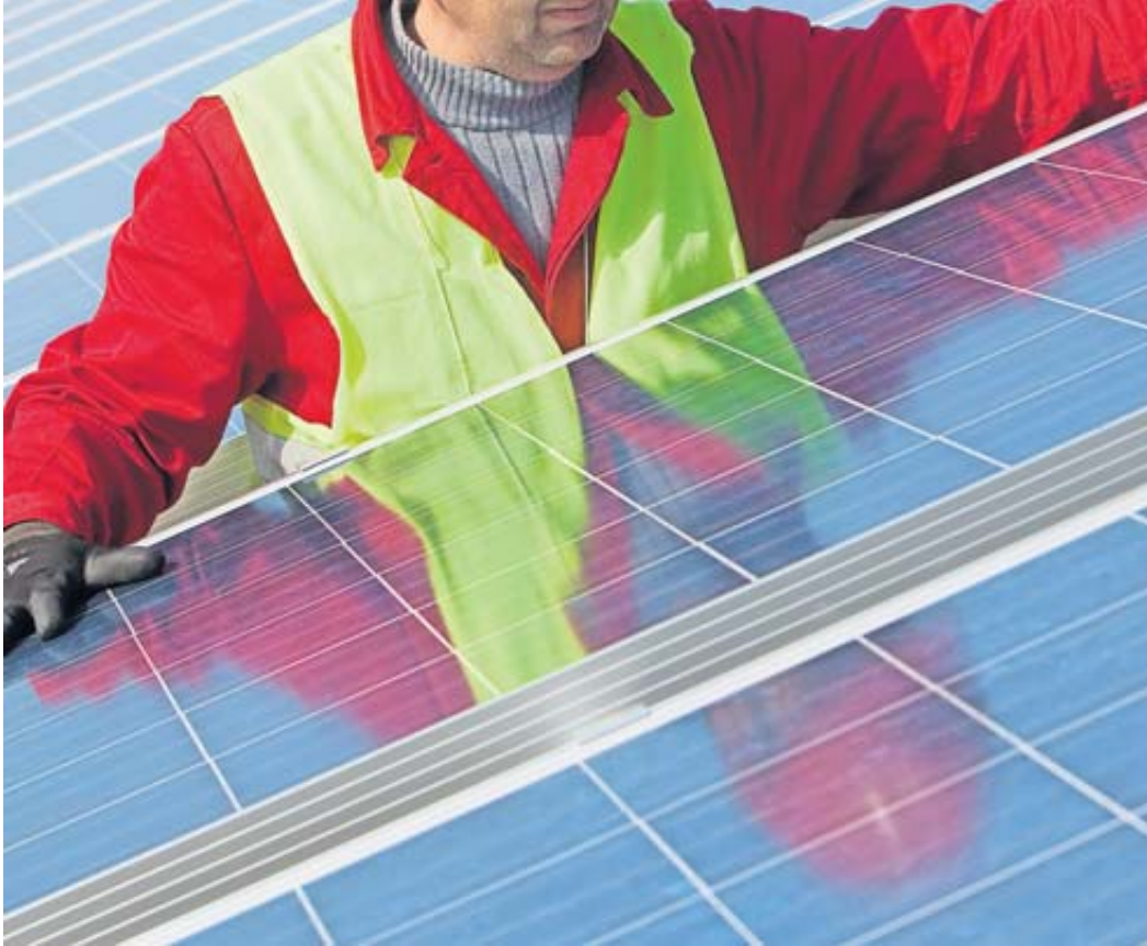
Die Module einer Photovoltaik-Anlage erzeugen Strom aus Sonnenenergie. Foto: Patrick Pleul/dpa-Zentralbild/dpa-mag
