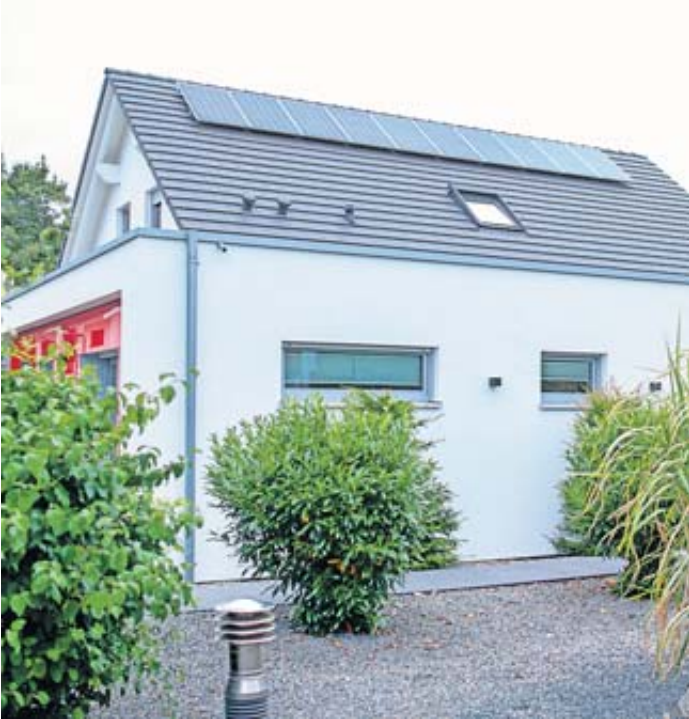
Mit einer Solaranlage auf dem Dach ist ein Haus unabhängiger vom Energiemarkt - und von seinen schwankenden Kosten. Foto: Laura Ludwig/dpa-mag
