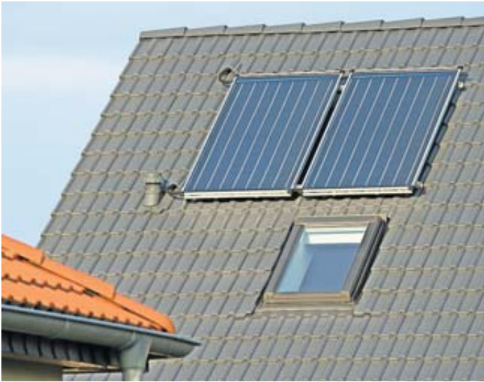
In den Kollektoren einer Solarwärmeeanlage fließt Wasser und Frostschutzmittel, die durch die Sonneneinstrahlung erhitzt werden. Foto: Andrea Warnecke/dpa-mag
