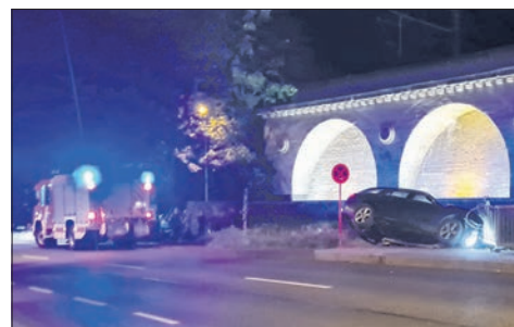
Der Unfallwagen hat das Brückengeländer an der B455 in Höhe der Bogenstützwand durchbrochen. Foto: privat
