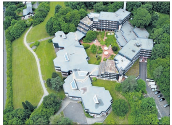
Die Luftaufnahme der GWH zeigt die ungewöhnliche Architektur des Akademiegebäudes.
