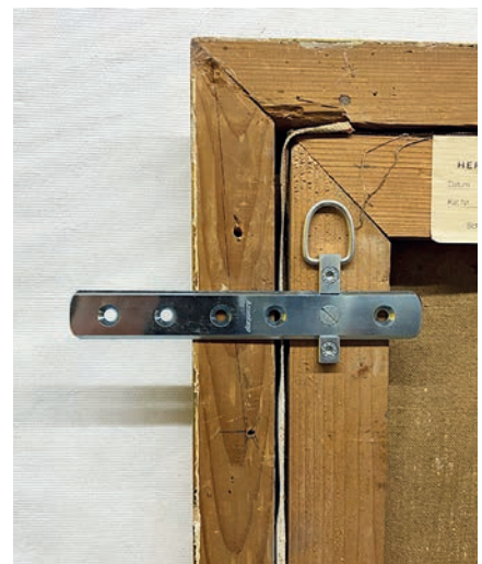
Modular und flexibel: Das inzwischen 30 Jahre alte Hängesystem ist sowohl ein Montage-, ein Transport- als auch ein Depotsystem.
