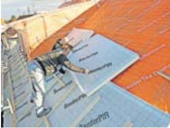
Bei der sogenannten Aufsparrendämmung erhält das Dach eine lückenlose Dämmschicht. Foto: DJD/Paul Bauder
