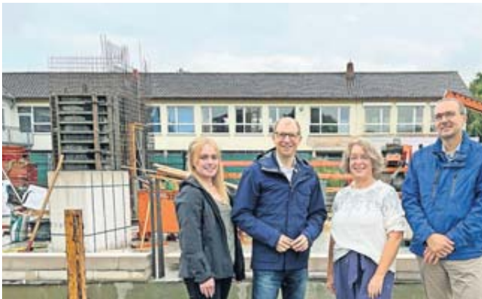
Beim Baustellenbesuch (von links): Projektleiterin Antonia Koch, Landrat Jan Weckler, Schulleiterin Anja Wall und Alexander Hiemer, Fachdienstleiter Hochbau.
