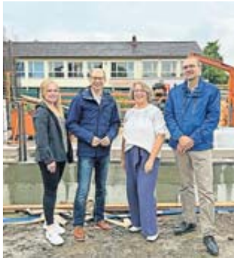
Beim Baustellenbesuch (von links): Projektleiterin Antonia Koch, Landrat Jan Weckler, Schulleiterin Anja Wall und Alexander Hiemer, Fachdienstleiter Hochbau.
