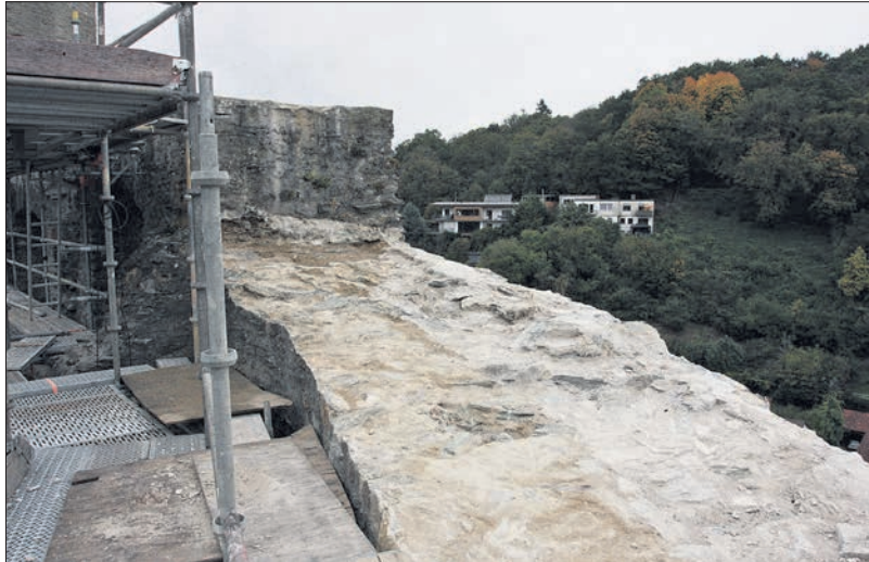
Die oberste Steinschicht und der Betonabschluss der Mantelmauer werden abgebrochen und mit Natursteinen neu aufgemauert. Foto: B. Schuchard-Palmert
