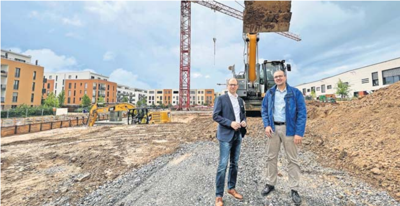
Landrat Jan Weckler (links) und Alexander Hiemer, Leiter des Fachdienstes Hochbau, besichtigen die Baustelle der neuen Bad Vilbeler Grundschule.
