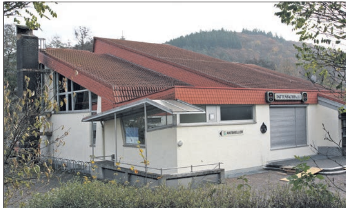
Ein Teil des Geldes aus der Erbschaft will die Stadt für die energetische Sanierung der Dattenbachhalle verwenden. Foto: EZ-Archiv
