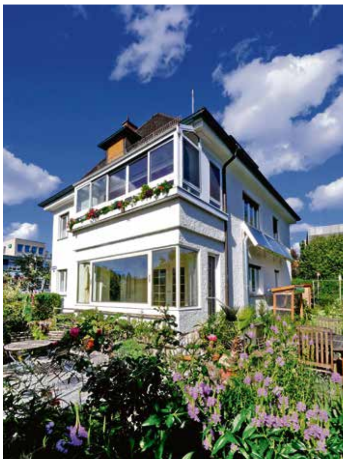
Eine Solarlüftung an der Südfassade sorgt jetzt für ein besseres Raumklima im Keller.
