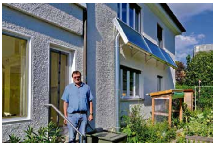
Der Amberger Hauseigentümer Bernhard Streich ist von den Vorteilen der Solarlüftung für den Keller überzeugt.
