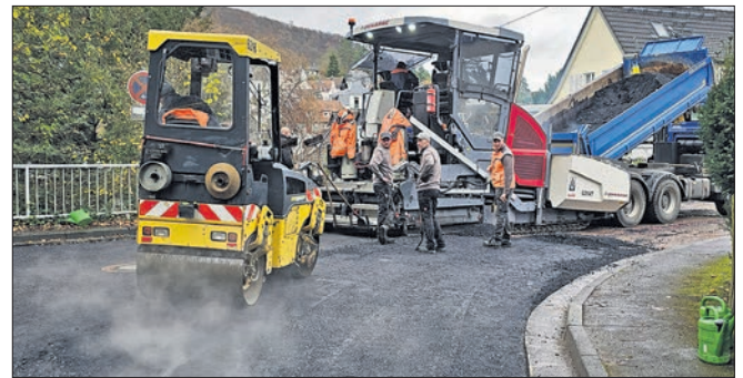
Asphaltarbeiten in der Cuntzstraße.
