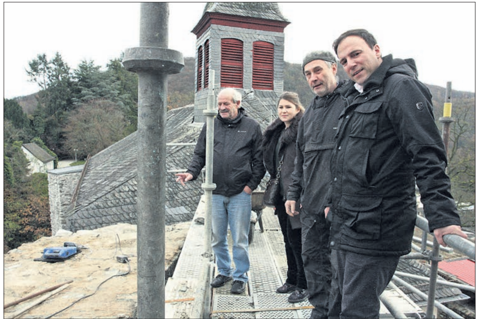
Alwin Dörr, Stefanie Münch, Michael Grimm und Alexander Simon (v.li.) vor der noch offenen Mauerkrone der Mantel- oder Schildmauer an der Nordseite der Burg. Foto: Schuchard-Palmert
