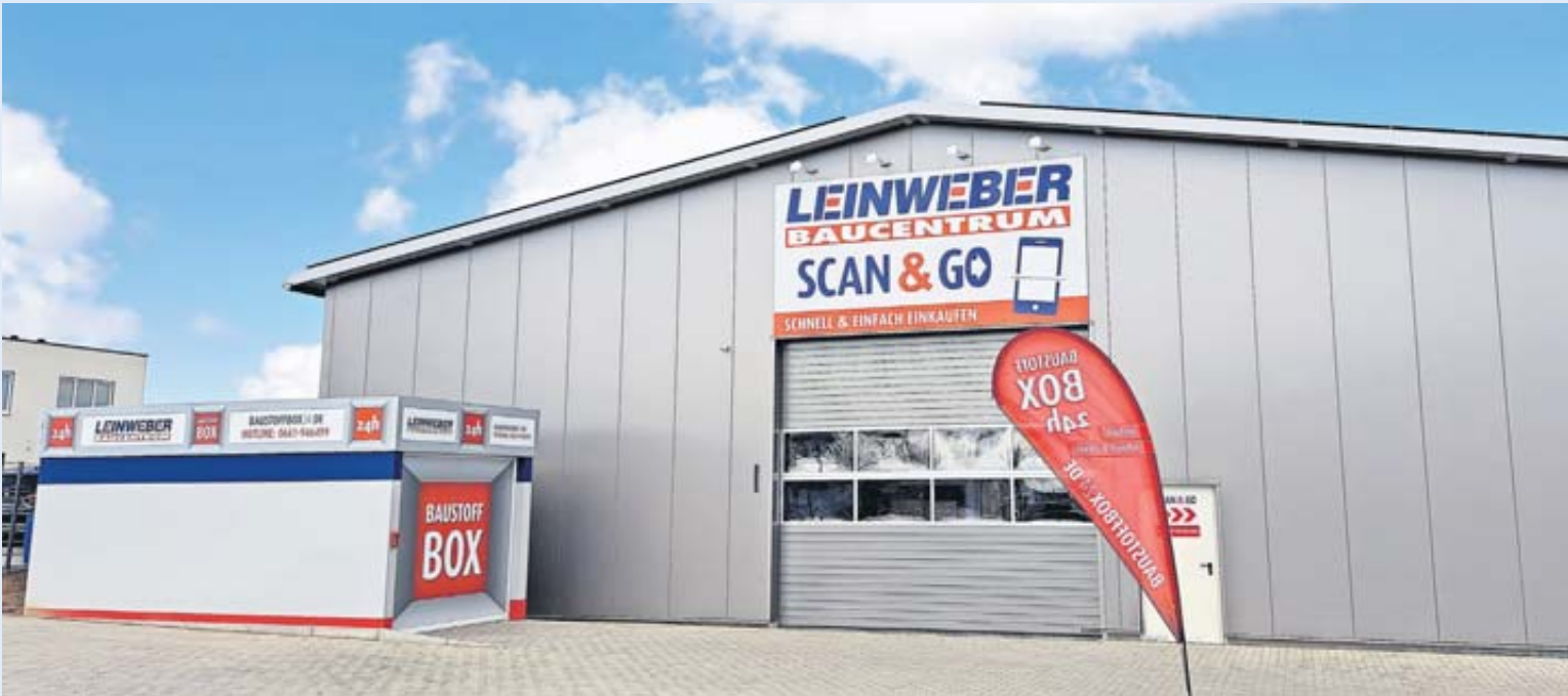
Die beiden Märkte in Hünfeld und Petersberg sind jeweils mit einer Baustoffbox ausgestattet.
