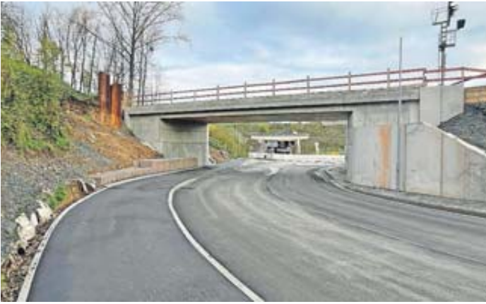
Unser Foto zeigt den aktuellen Stand der Bauarbeiten mit dem neuen Geh-/Radweg im Be-reich der Unterführung Görbelheimer Hohl.
