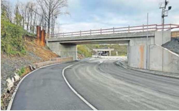
Unser Foto zeigt den aktuellen Stand der Bauarbeiten mit dem neuen Geh-/Radweg im Be-reich der Unterführung Görbelheimer Hohl.
