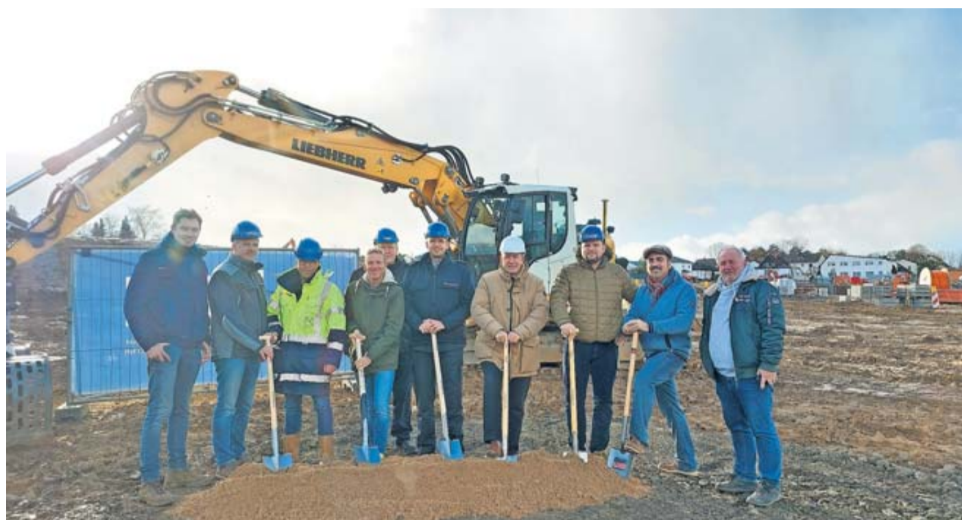
Beim ersten Spatenstich zum neuen Petterweiler Feuerwehrhaus: Bauunternehmer Eric Schrempf, Harald Kirch vom Kommunalen Immobilienmanagement, Architekt Marc Jacobs, Stadtrat Stephan Theiß, stellv. Leiter Stadtpolizei Uwe Axtmann, stellv. Stadtbrandinspektor Martin Strehl, Bürgermeister Guido Rahn, Rene Rapior, Ortsvorsteher Dennis Vesper und Joachim „Schöni“ Schönberger. (von links)
