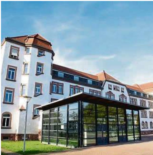
Die Gebäude des Schulzentrums Hessen-Homburg sollen durch einen neuen Trakt miteinander verbunden werden. Die Bauarbeiten sollen 2025 beginnen. FOTO: MICHAEL PROCHNOW
