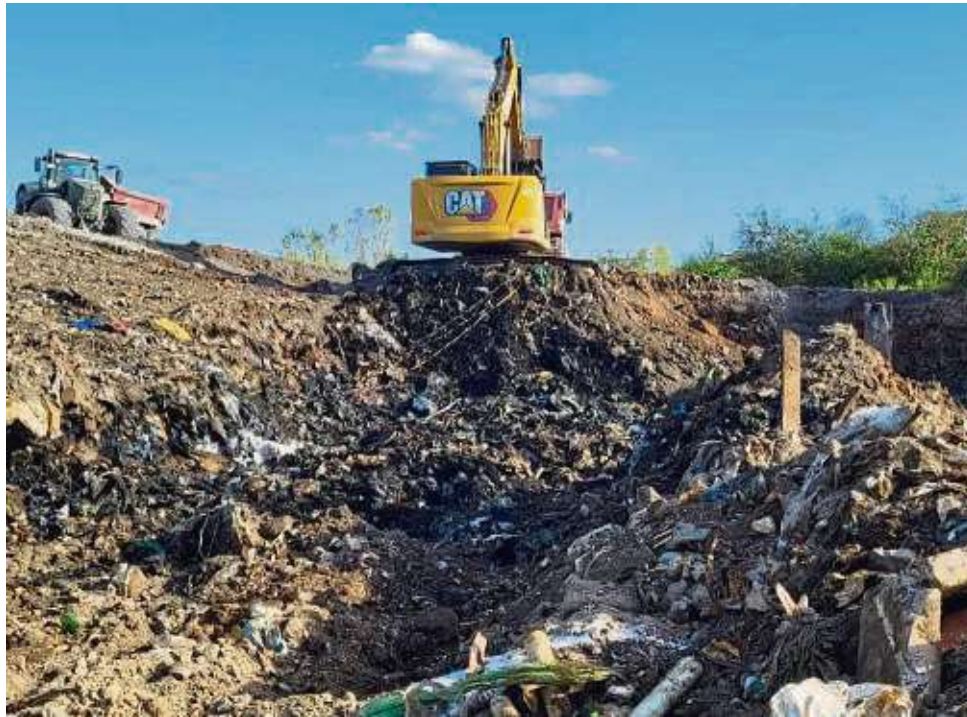
Die Sanierungsfirma beim Voraushub: Auf dem neun Hektar großen Areal wurden bis in die späten 1970er Jahre Millionen von Tonnen an Abfällen entsorgt.
