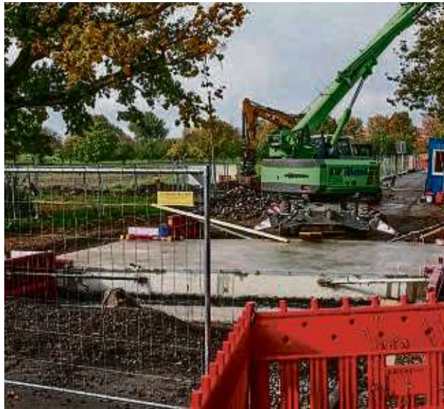
Nach Auskunft von Hessen Mobil soll die Verkehrsfreigabe auf der L 3445 noch vor den Weihnachtsfeiertagen erfolgen; nach halbjähriger Vollsperrung ist die Ortseinfahrt bei Rüdigheim dann wieder passierbar. FOTO: AXEL HÄSLER
