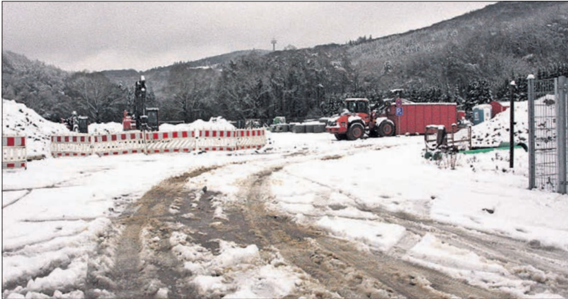
Die größte Investition 2024: Kurz nach Beginn der Erschließungsarbeiten für die Kita an der Embsmühle kam der erste Wintereinbruch. Jetzt ist Winterpause. Foto: bpa
