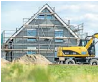
Ein Baugrundgutachten sollte klären, wie der Boden beschaffen ist. Foto: Hauke-Christian Dittrich/dpa/dpa-mag
