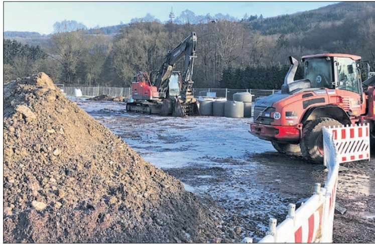
Anfang der Woche herrschte noch Winterpause auf der Baustelle an der Embsmühle. Foto: Julia Palmert
