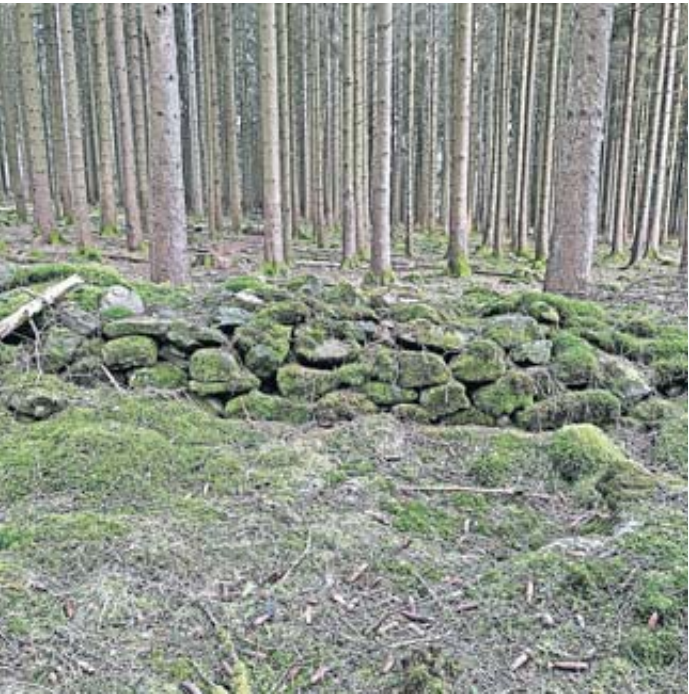
Teilstück der ehemals 200 m langen „Scheidmauer“ auf einer Weide des Gestüts Steinau. Foto: R. Geschwindner
