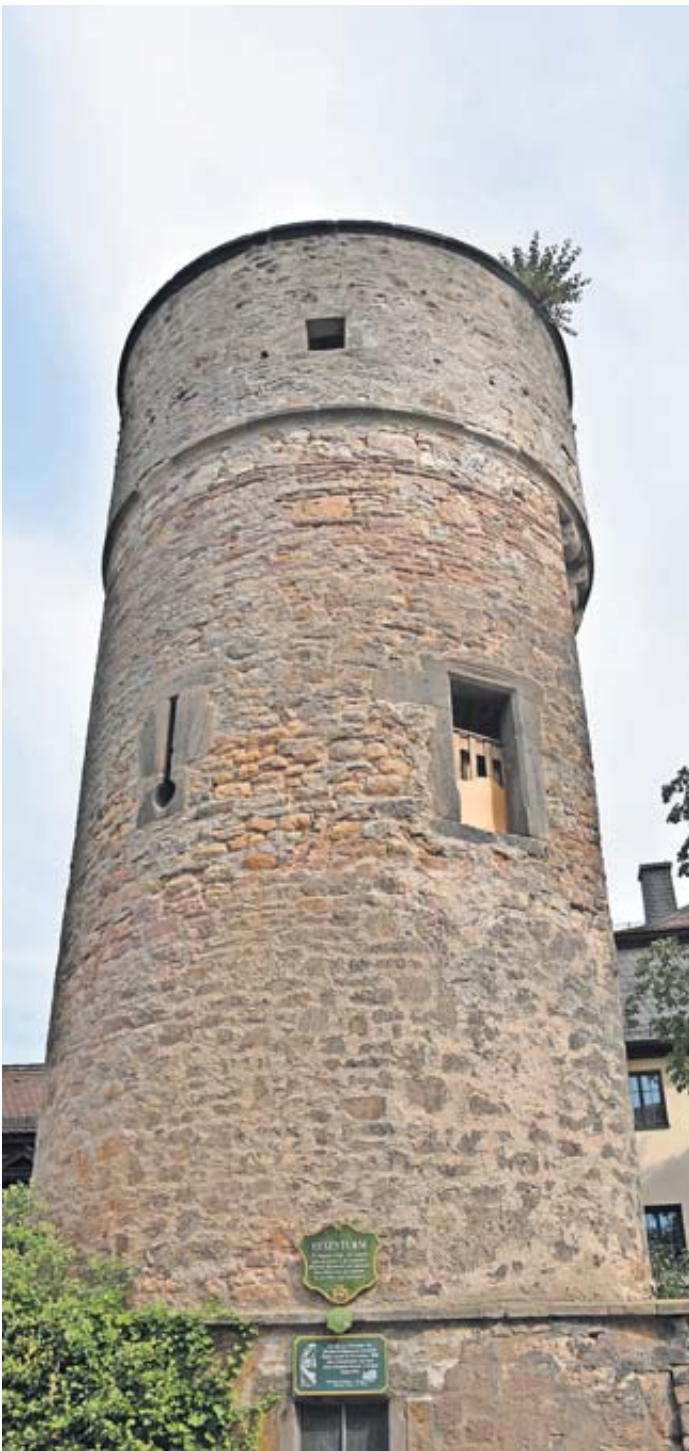
Der historische Hexenturm wird saniert
