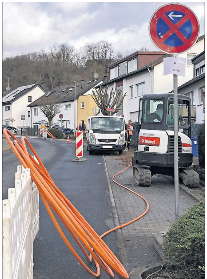
Die Arbeiten in der Rosserstraße gingen zügig voran.
