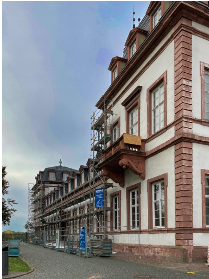
Außenrenovierung des „Papiertheaterflügels“
