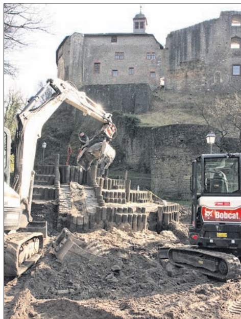
Unter der Burg sind die Bagger angerückt.
