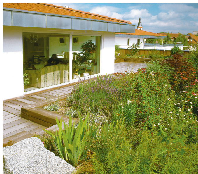
Eine Dachbegrünung verbessert das Mikroklima vor Ort und schafft neue, dringend benötigte Lebensräume für Vögel und Insekten.
