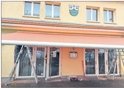
Die neue Markise am „Alten Spritzenhaus“ wird montiert. Foto: privat
