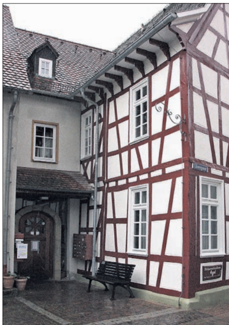
Ein Aushang an der Eingangstür informierte die Bewohner des Fliednerhauses über Arbeiten an der Heizung Anfang der Woche.
