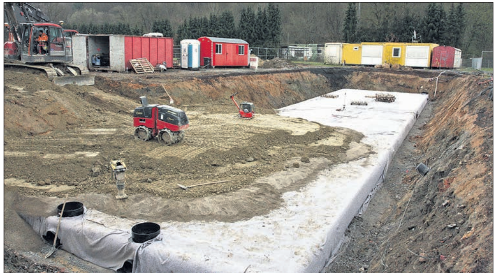
Eine Regenrückhalterigole, ein flacher aus Modulen zusammengesetzter Pufferspeicher, wird komplett mit Erdaushub abgedeckt, damit darauf später ein Parkplatz gebaut werden kann. bpa
