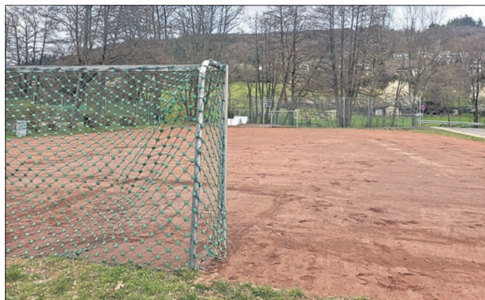
Nach der Anbringung der Markise am Bistro Altes Spritzenhaus wurde nun auch der Bolzplatz in Ehlhalten bearbeitet. Die Oberfläche wurde abgetragen und neues Material aufgebracht.
