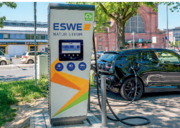
Die erste Schnellladesäule (High Power Charging) am Hauptbahnhof mit einer Maximalleistung von 140 Kilowatt aus ESWE Natur STROM. Bild rechts: Das RheinMain Congress Center ist mit E-Ladeboxen von ESWE ausgestattet.
