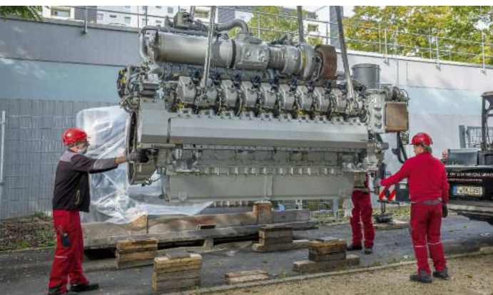
Remotorisierung des Moduls 3 im Fernwärmeheizwerk Klarenthal.
