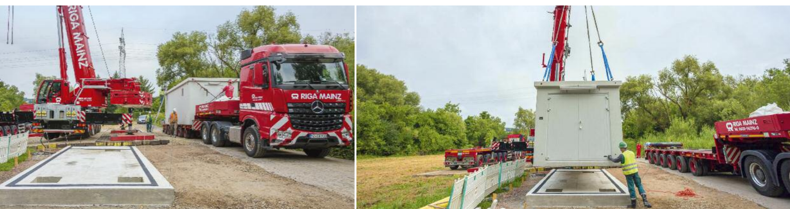
Anlieferung und Montage der neuen Gasdruckregelstation „Grunselsbörnchen“.
