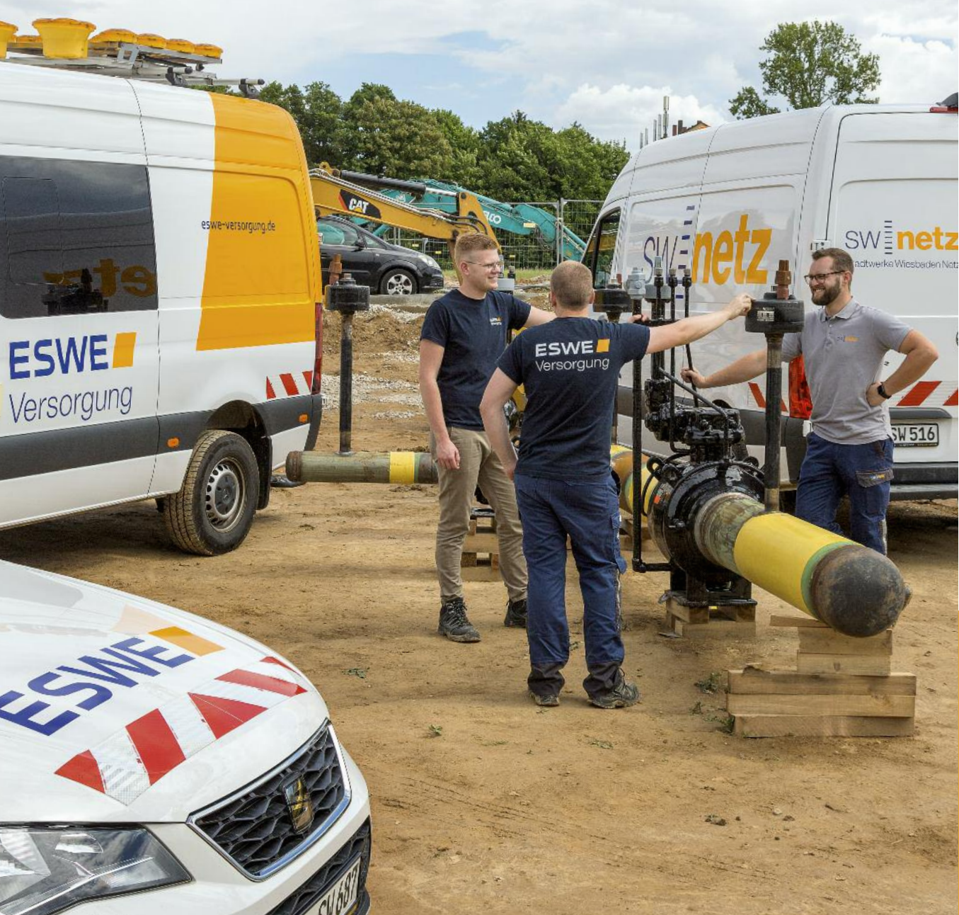
Gashochdruckanschluss für die Nahwärmestation im neuen Baugebiet „Auf den Eichen“ im Stadtteil Gräselberg.
