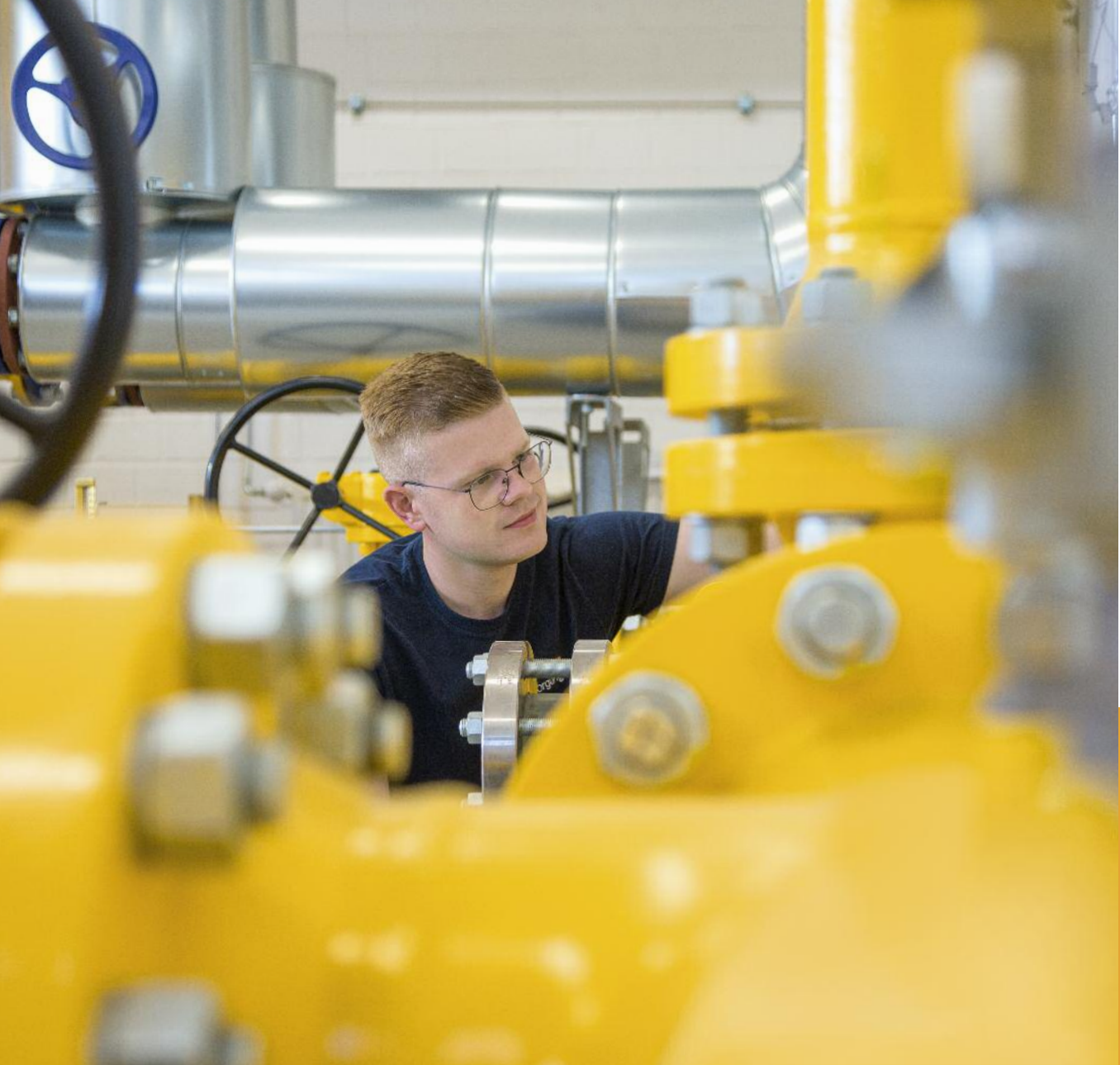
Erneuerung Gasübergabestation „Erbenheimer Weg“
