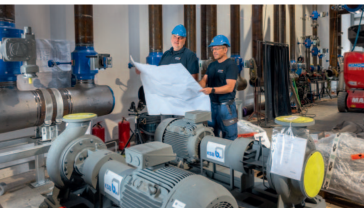
Neue zentrale Pumpstation zur Erzeugung und Verteilung für das Biomasse-Heizkraftwerk und das im Bau befindliche Müllheizkraftwerk.
