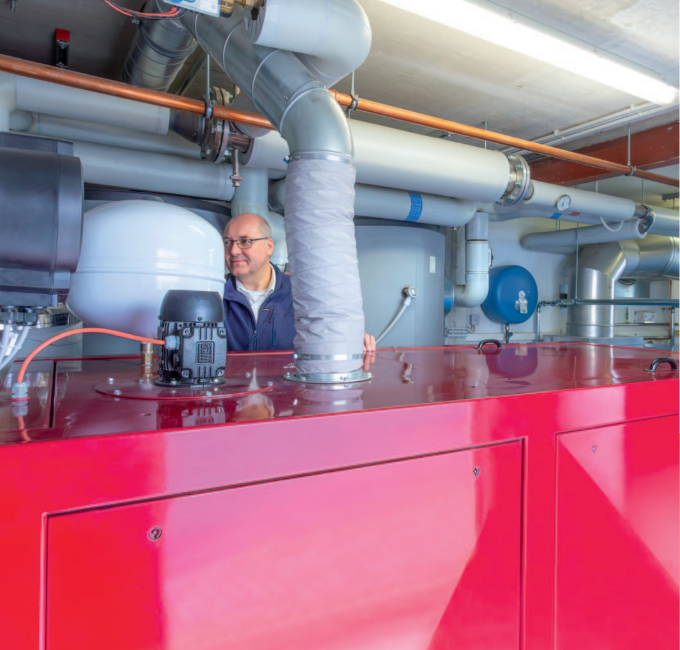
Erneuerung des Nahwärmenetzes in Taunusstein-Hahn für ein Wohn- gebiet und Seniorenheim.
