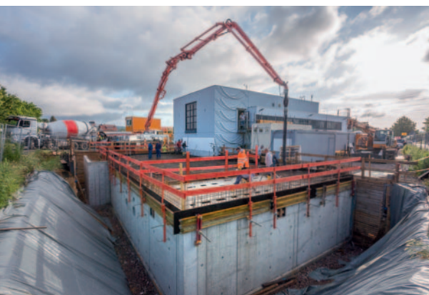
Baustelle Umspannwerk Wiesbaden-Bierstadt.
