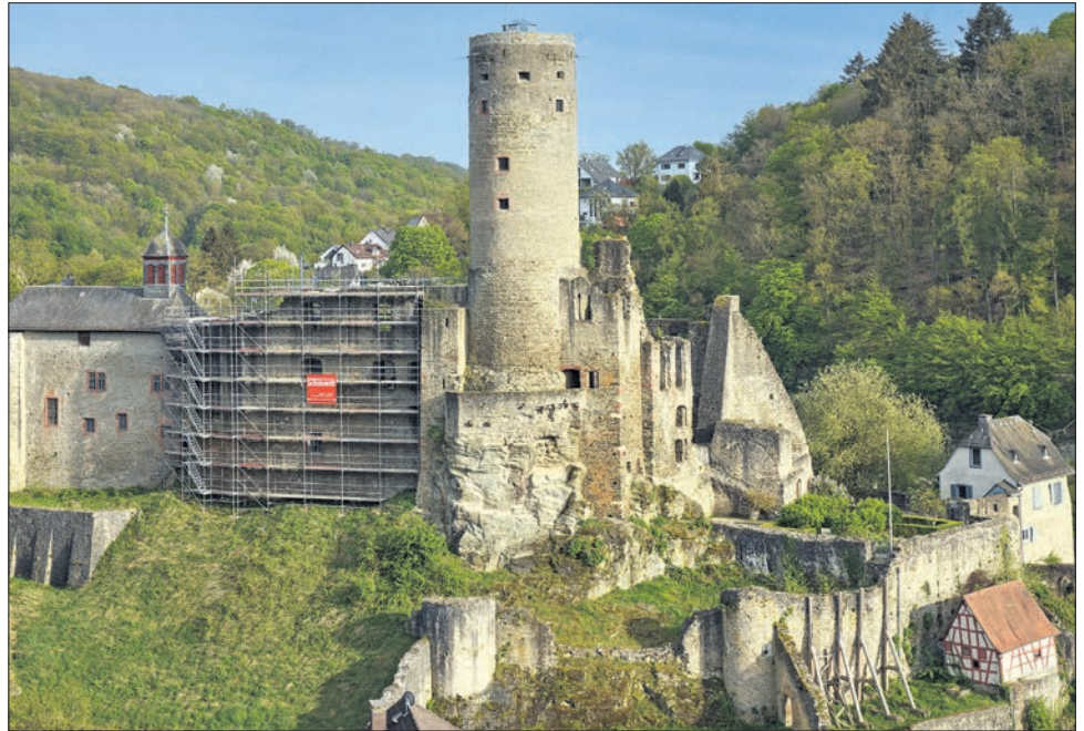
Das neue Gerüst an der Nordmauer.
