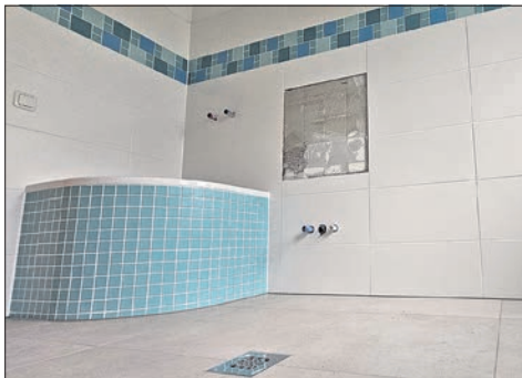
In der Kita Am Vogelgesang in Bremthal werden die Sanitäranlagen erneuert.
