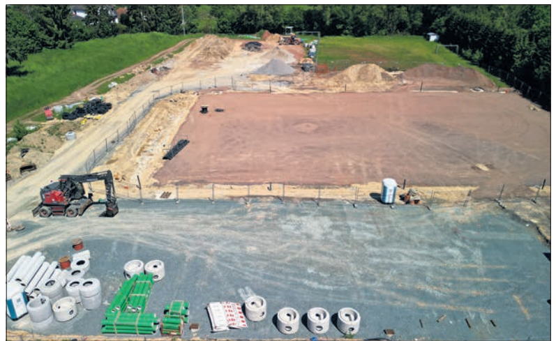
Der neue Multifunktionsplatz an der Embsmühle nimmt Gestalt an. Ein neuer Weg und zusätzliche Parkplätze entstehen. Drohnen-Foto: Jochen Haupt
