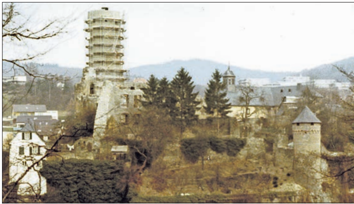
Einrüstung des Bergfrieds 1971. Mauern und Zwinger der Burg waren noch nicht von wuchernden Pflanzen befreit. Foto: BEPA GmbH
