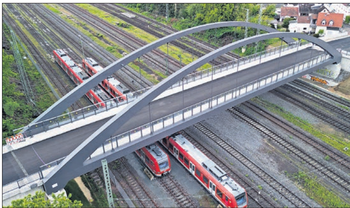
Die neue Brücke in Niedernhausen ist fertig.
