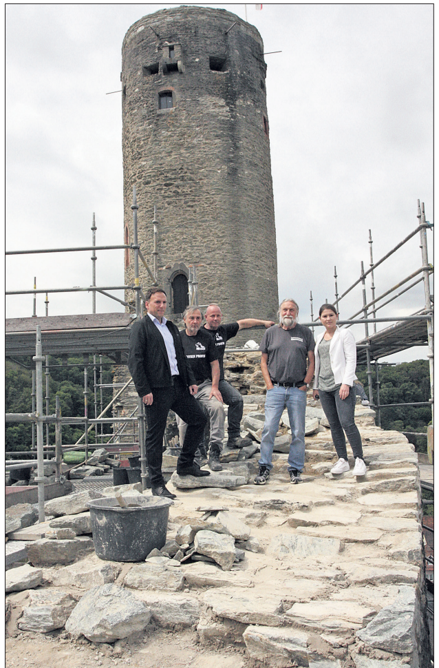
Alexander Simon, Michael Grimm, Martin Burkhard, Joachim Zeune, Stephanie Münch (v.li.) auf der Mauerkrone. Foto: bpa
