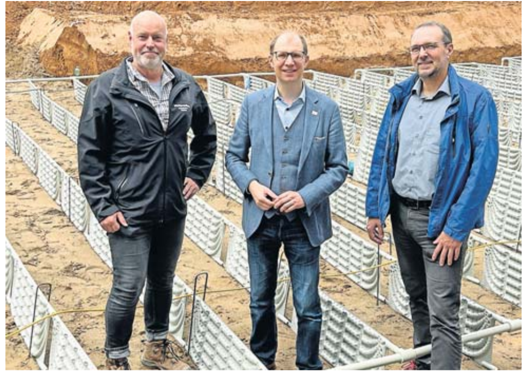
Landrat Jan Weckler begutachtet gemeinsam mit Alexander Hiemer (rechts, Fachdienstleiter Hochbau) und Projektleiter Thomas Zimmer (links) die Baustelle für die neue Erdkollektoranlage.
