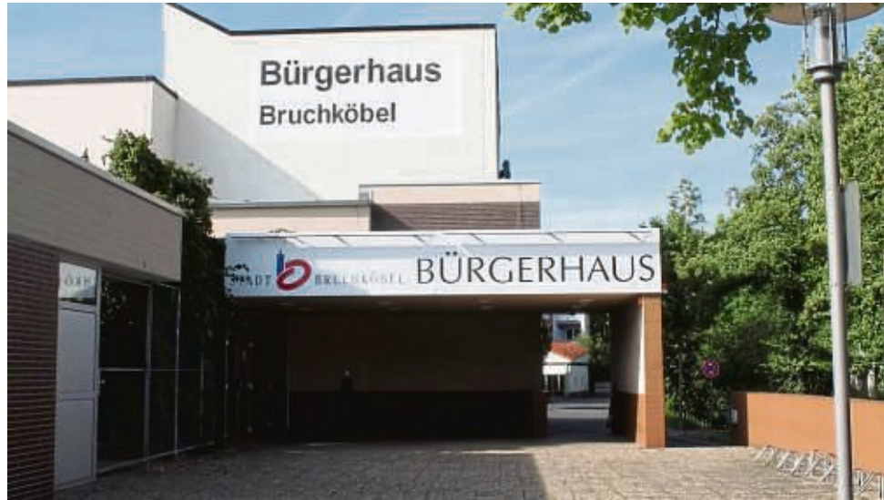
Das Bürgerhaus im Zentrum von Bruchköbel: Der letzte Abrisstermin ist verstrichen, einen neuen Termin gibt es noch nicht.
