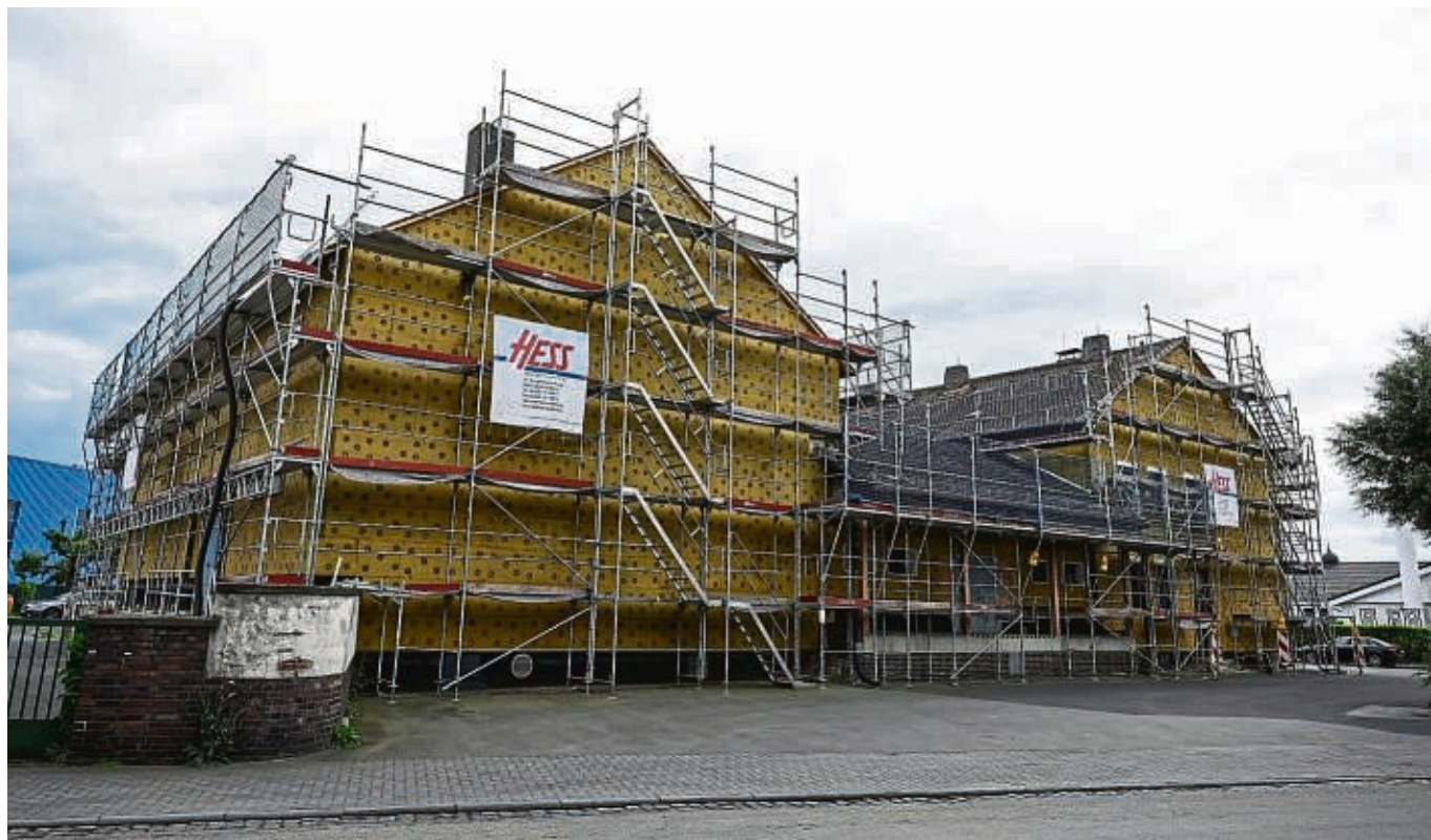
Das Zollamt Hanau wird derzeit energetisch saniert. Die alte Fassade ist dahinter verschwunden.
