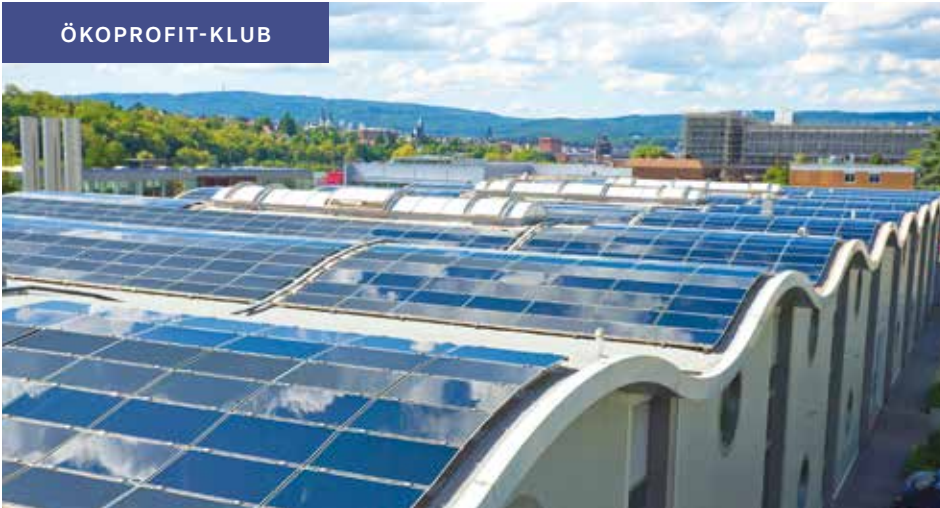
147,68-kWp-Photovoltaikanlage auf dem Lagergebäude der ESWE Versorgung AG
