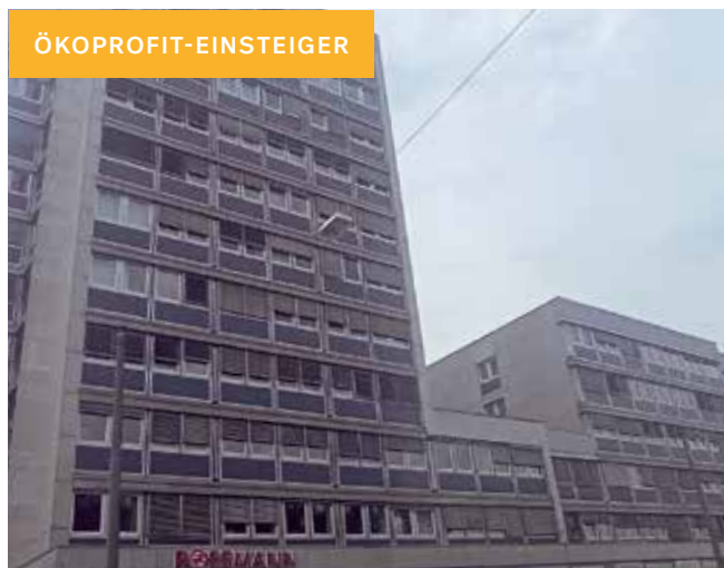
Blick auf gesamtes Gebäude
