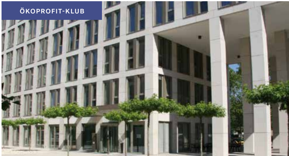
SOKA-DACH im Büroquartier VERSO in Wiesbaden
