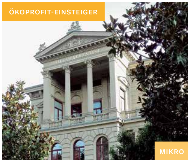
Literaturhaus Villa Clementine – Außenansicht
