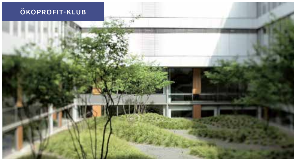
Innenhof des SOKA-BAU-Hauptgebäudes
