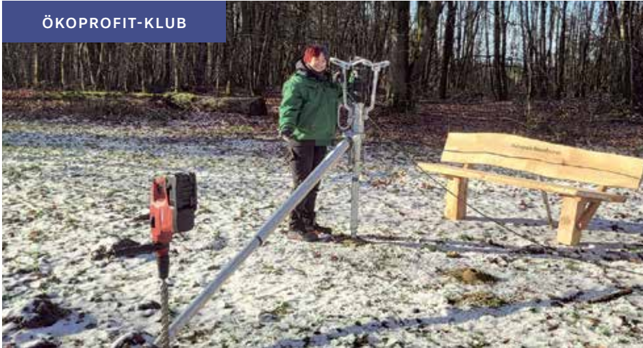
Neues Fundamentsystem im Einsatz
