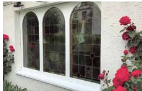
Einbau einer alten Bleiverglasung in moderne Fenster mit Dreifachverglasung
