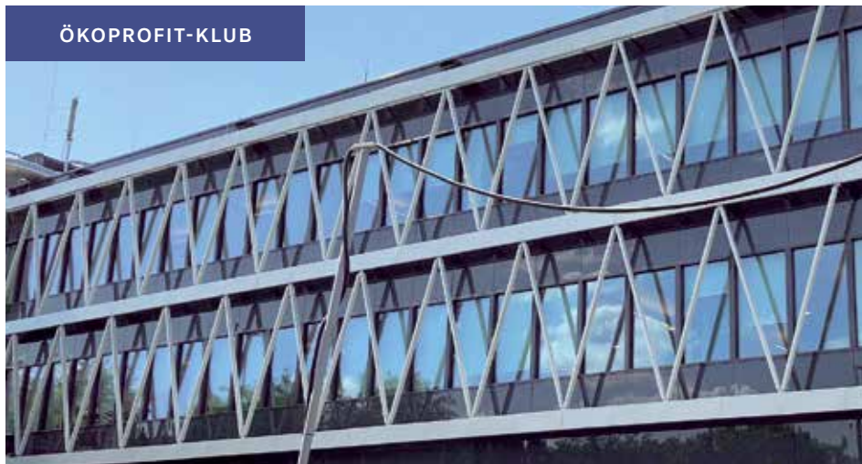
Die neue Fassade am Hauptsitz
