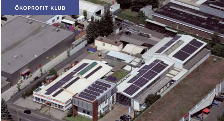
Gelände der Firma Huhle mit Photovoltaikanlagen
