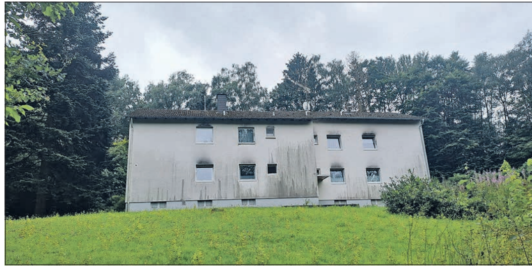
In der Altkönigstraße 176 befinden sich vier Wohnungen, um die sich der BSO kümmern soll, die aber in keinem guten Zustand sind. Foto: gt
