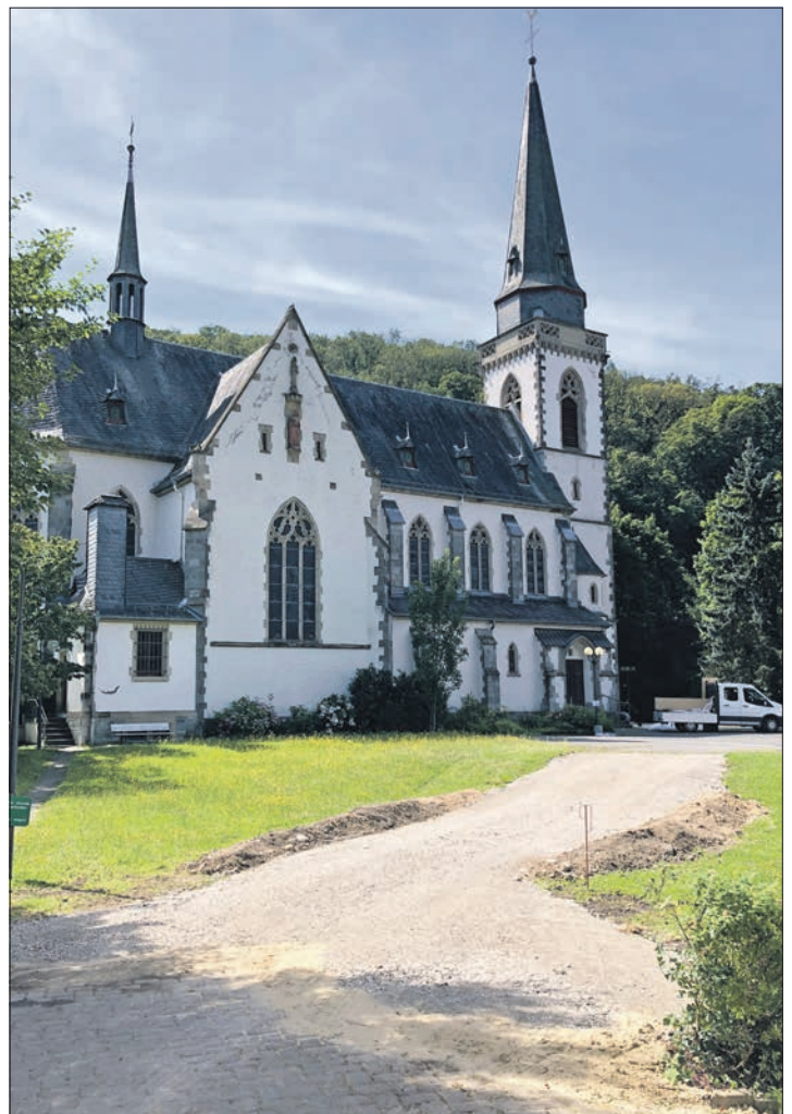
Für die Dauer der Baurbeiten an der Laurentius-Kirche muss die Rasenfläche einer Baustraße weichen. Foto: Julia Palmert
