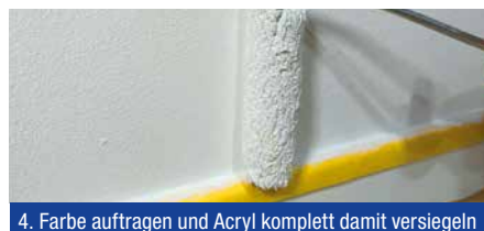
4. Farbe auftragen und Acryl komplett damit versiegeln
