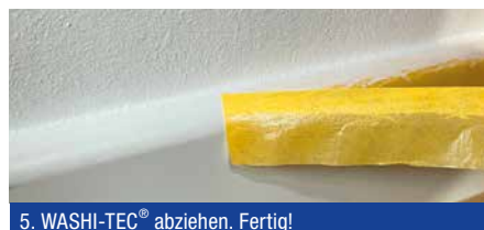
5. WASHI-TEC® abziehen. Fertig!
