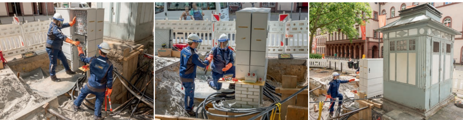
Vorbereitungen zur Erneuerung einer denkmalgeschützten Trafostation.
